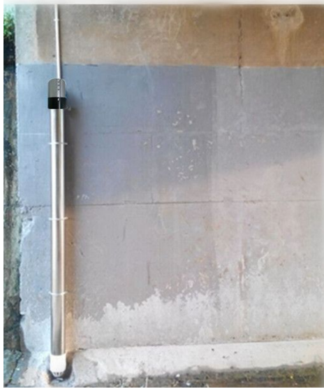
雷达水尺涵洞安装
