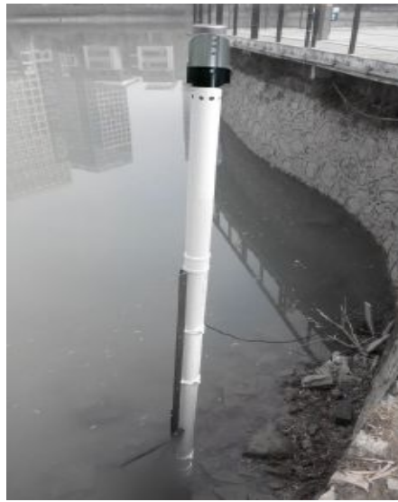
激光水尺立柱安装
